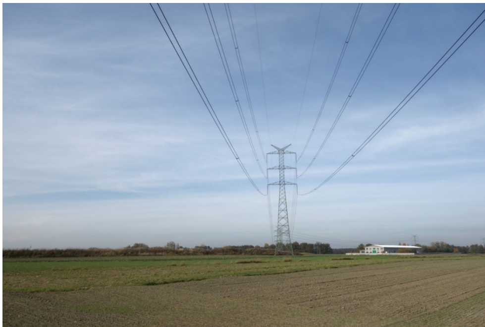
Ryc. 12 Dwutorowa linia elektroenergetyczna wysokiego napięcia 400 kV Źródło: Fotografia wykonana przez autora prognozy, październik 2021r.
